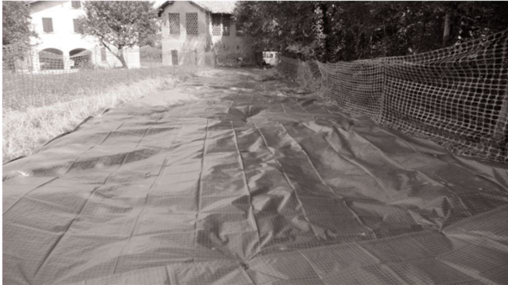
Figura 1 - Area dopo la messa in sicurezza d'emergenza
