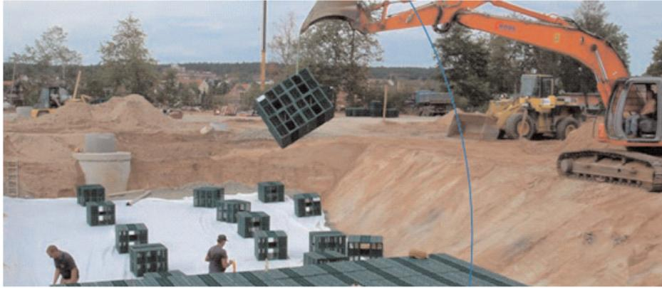
Figura 1 - Posa di un sistema del tipo "a gabbioni filtranti"
